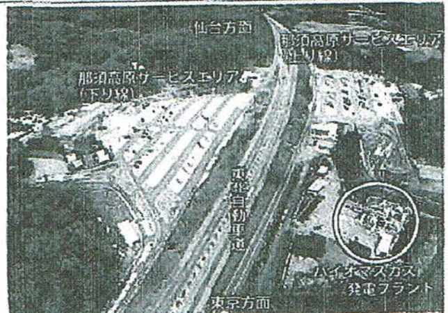
プラントを整備した那須高原SA付近
